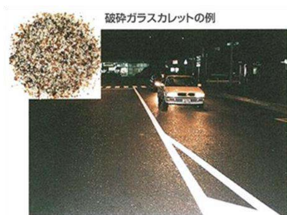
圖 2.4 日本廢玻璃工程鋪面實景 [2.9]
