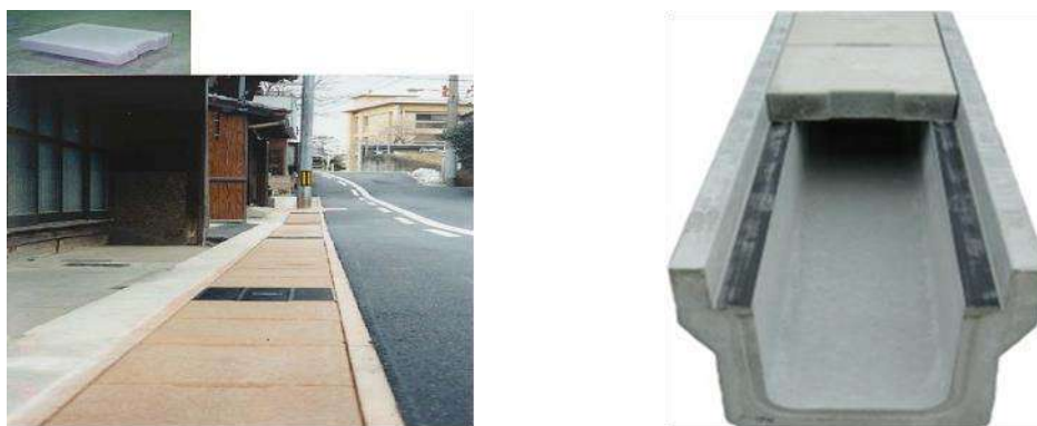
圖 2.3 預鑄水溝蓋中加入廢玻璃(含量佔粒料之 54.4 %) [2.9]
