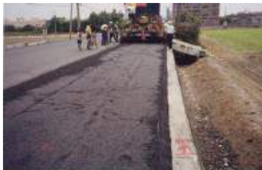
圖 2.9 玻璃瀝青混凝土路面試鋪 (雲林 156 縣道) [2.13]
