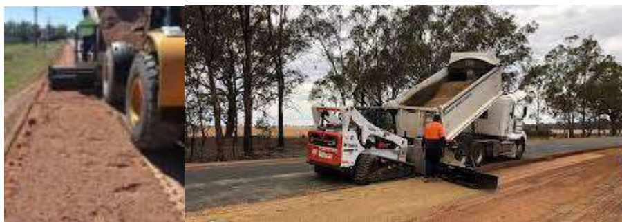
圖 2.7 澳洲新南威爾斯省洛克哈特郡應用廢玻璃於道路底層鋪設 [2.11]
