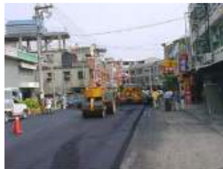
圖 2.10 玻璃瀝青混凝土路面試 鋪(雲林 158 縣道) [2.13]
